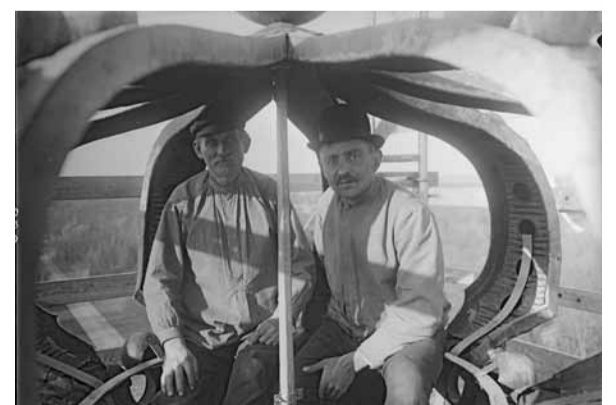
Ansicht der Krone über den Grazien auf der Mittelkuppel des Neuen Palais bei Restaurierungsarbeiten, 1910 – 1920. © SPSG
