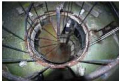
Wendeltreppe im Turm verbundenen Geschosse aus Eisengussplatten so verrostet,
