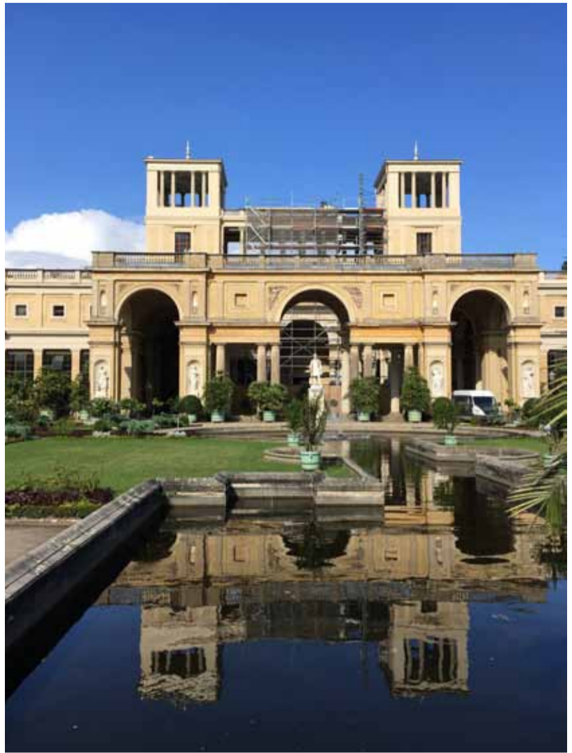
Oben: Abbau der Gerüste am Orangerieschloss: Nun präsentiert sich der Mittelbau der imposanten Schlossanlage wieder in ursprünglicher Farbfassung. Links: Restaurierte Sandstein-Säulenkapitelle der Türme. Fotos: Jana Giesa
