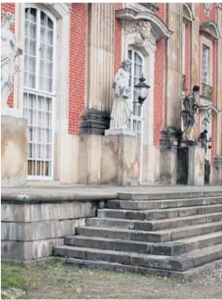
Sandsteinsockel: Eindringendes Grundwasser sowie Nässe und Feuchtigkeit von oben haben zu erheblichen Schäden geführt.
