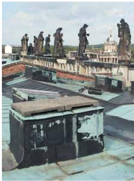
Kupferdach: An vielen Stellen ist das Dach undicht, so dass Regen und Schnee Wasserschäden verursacht haben.
