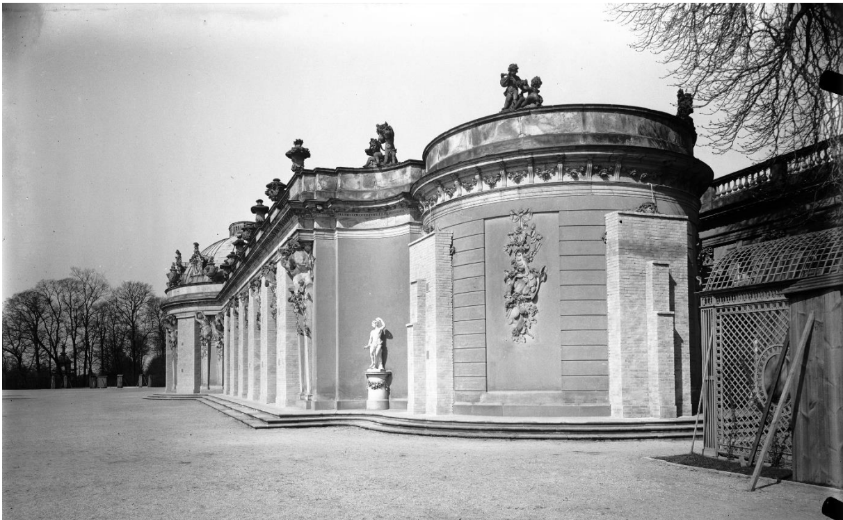
Abb. 6: Potsdam, Schloss Sanssouci, 17. April 1941, Blick auf den westlichen Eckpavillon, Splitterschutz an Fenstern und Fenstertüren des runden Bibliothekszimmers von Sanssouci, © SPSG
