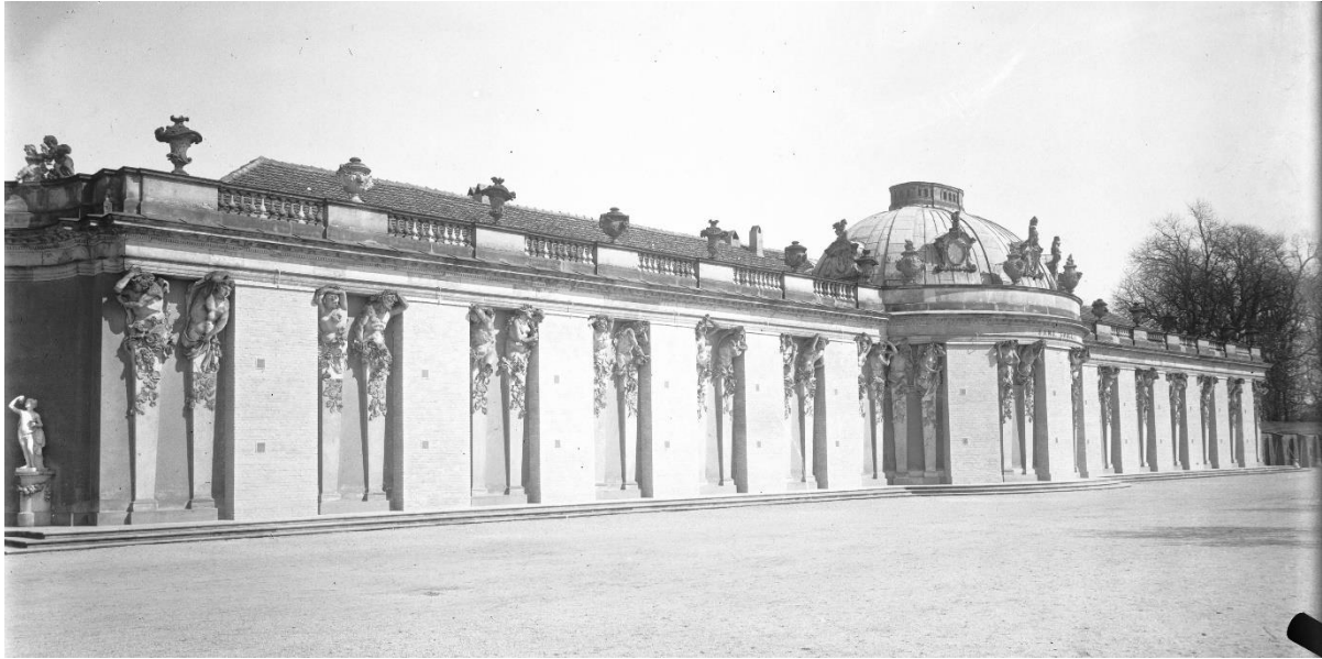
Abb. 5: Potsdam, Schloss Sanssouci, 17. April 1941, nach Süden zeigende Gartenseite mit vermauerten Fensteröffnungen zum Bombsplitterschutz, © SPSG
